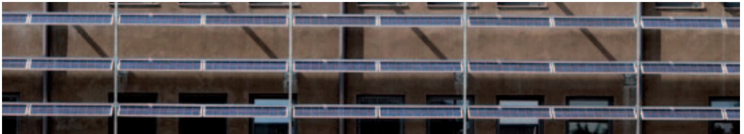
Impianto fotovoltaico frangisole, sede Cisl, Comune di Vicenza
