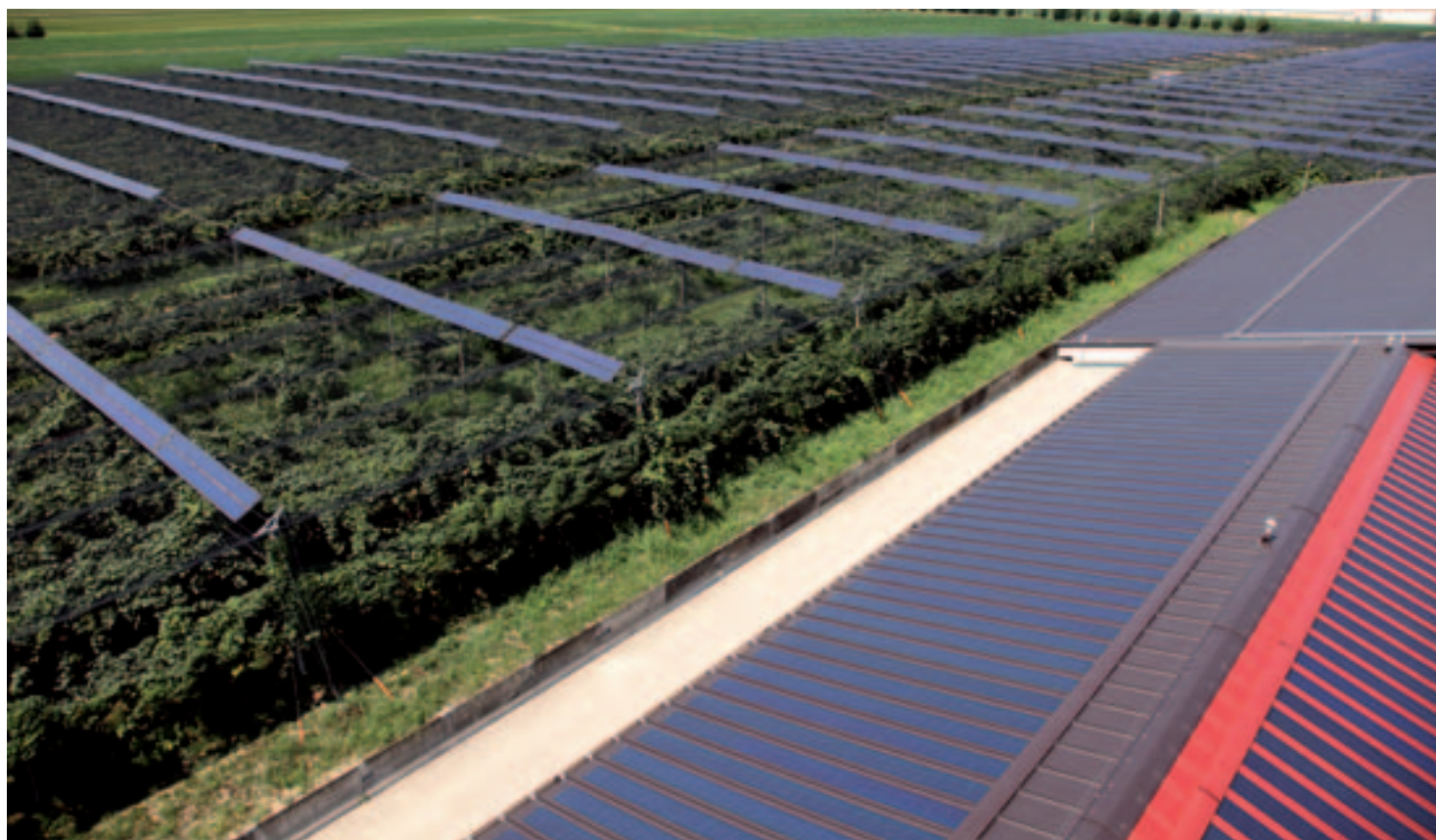
Impianto solare fotovoltaico "sospeso" su coltivazione di kiwi, Isola della Scala (VR) - foto di TEA Energie Srl
