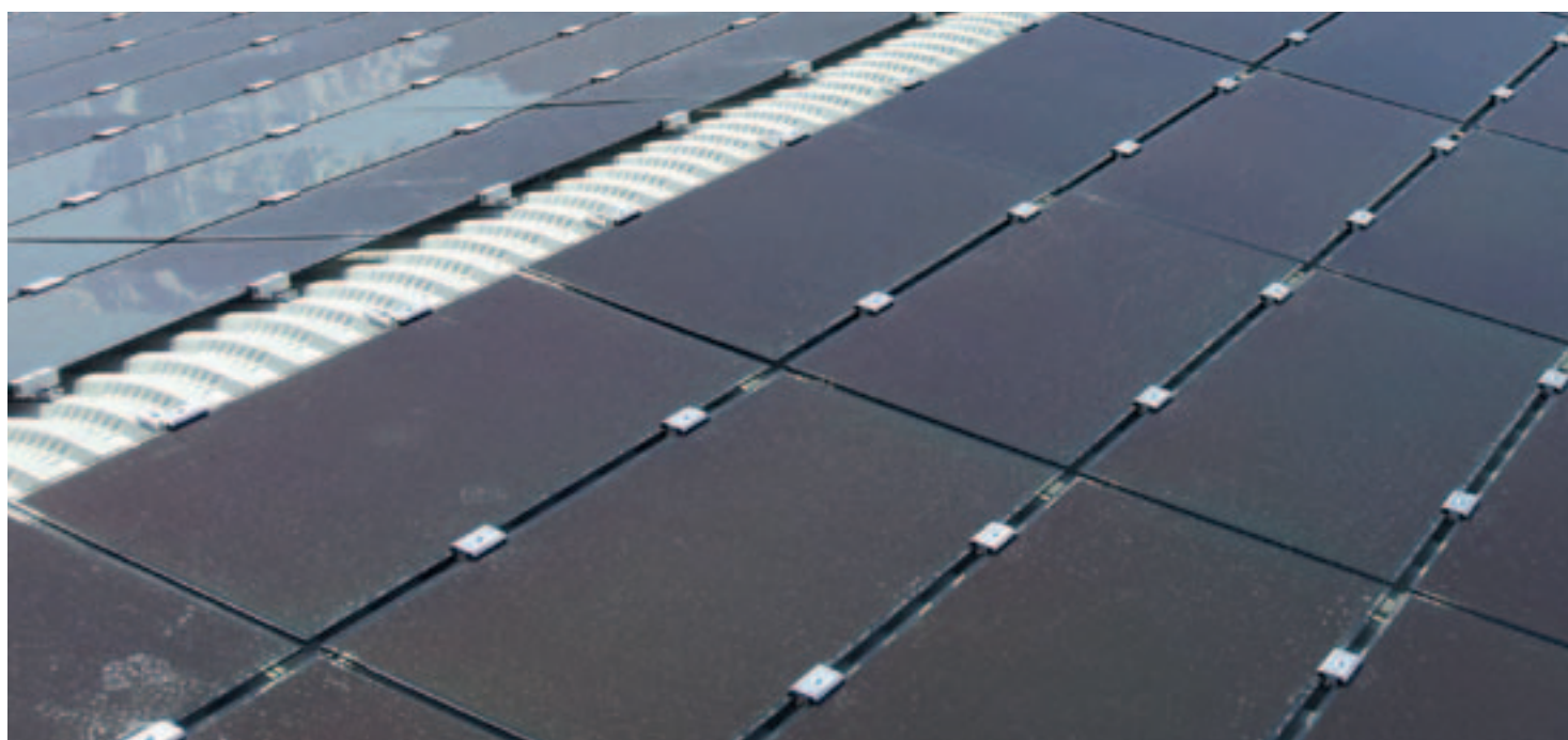
Impianto fotovoltaico in sostituzione dell'eternit, Comune dell'Aquila.
