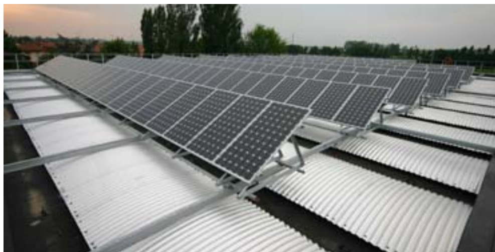
Impianto fotovoltaico palestra pubblica, Comune di Narni (TR)
