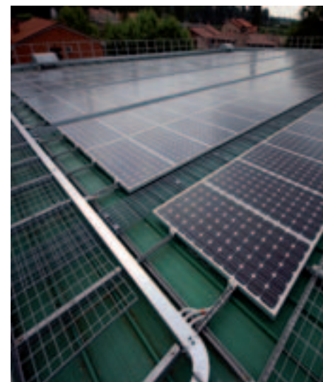
Impianto fotovoltaico sulla copertura della Chiesa San Marino, Comune di Bentivoglio (BO)
