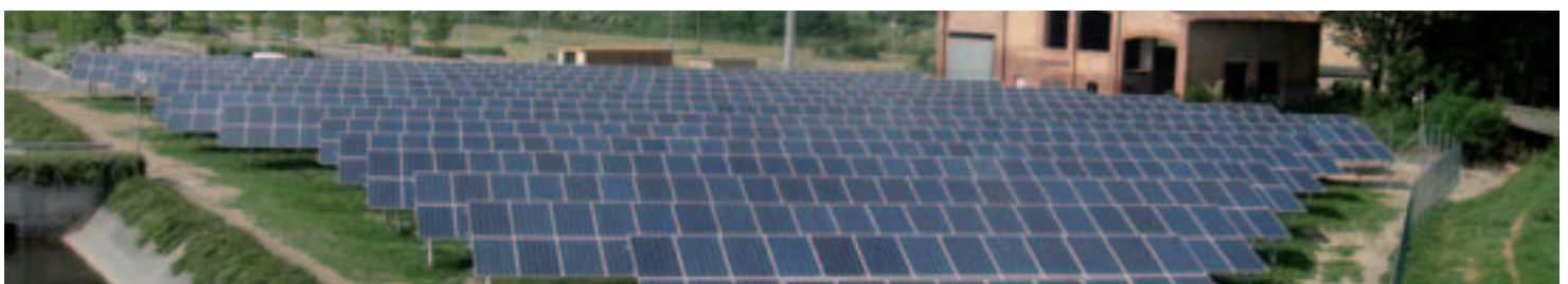
Impianti fotovoltaici con fissaggio a vite, Comune di Stanghella (PD). Foto di Fedi Impianti
