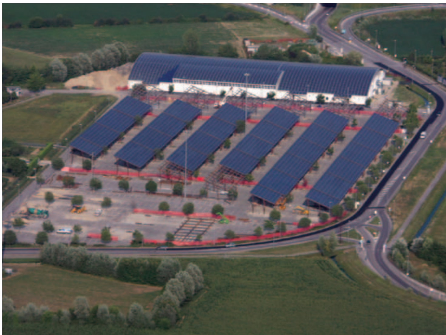
Impianto fotovoltaico su coperture Palazzetto dello Sport, Comune di Padova
