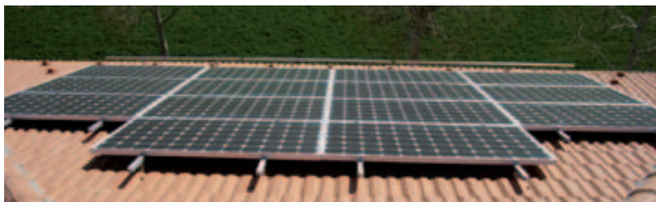
Impianto fotovoltaico scuola Spinetta, Comune di Cuneo
