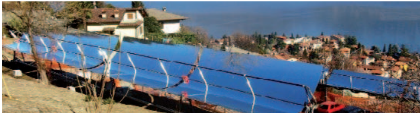
Impianto solare a concentrazione, Comune di Menaggio. Foto di Xeliox Srl
