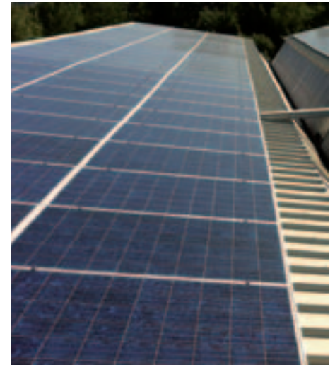
Impianto fotovoltaico Centro operativo servizi, Comune di Narni
