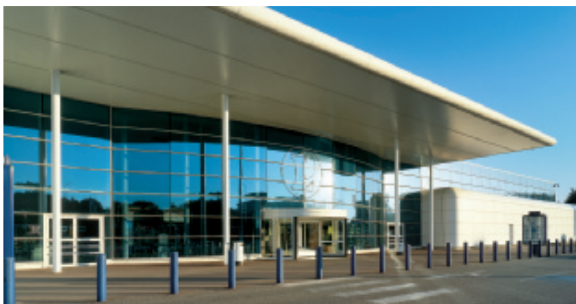
Edificio Leclerc - Neufchâteau - Francia - Stopsol Supersilver Dark Blue
