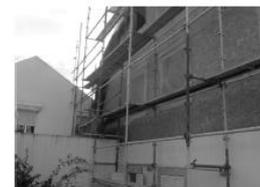
FIGURA 3 POSA IN OPERA DI ISOLAMENTO A CAPPOTTO IN FIBRA DI LEGNO
