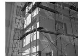
FIGURA 2 POSA IN OPERA DI ISOLAMENTO A CAPPOTTO IN MATERIALE POLIMERICO
