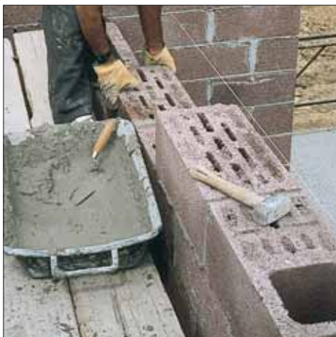
Posa di muratura armata in Lecablocco.
