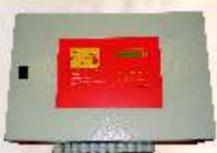
Quadro di controllo standard – regolazione SPS modulare – abbassamento notturno della temperatura – accensione automatica – modem per la regolazione a distanza – regolatore di circuito calorico (2 circuiti + acqua calda) - caldaia – fumi – regolatore di mandata estate – -inverno – tampone – boiler – funzionamento manuale – conta ore funzione – funzionamento controllato.
