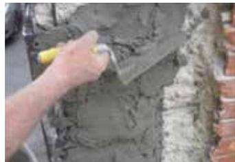
6\_ RIPRISTINO DEL COPRIFERRO DI SPESSORE ADEGUATO E RIPRESA DEL RIVESTIMENTO DEL RIVESTIMENTO
