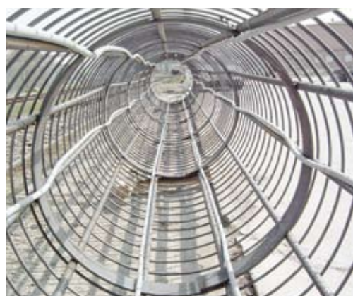
Pilastro di fondazione prima della posa
