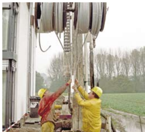
Installazione di una sonda geotermica RAUGEO
