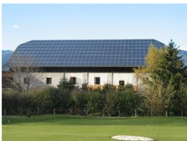
impianto su capannone
