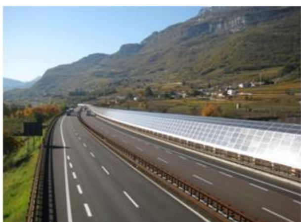
impianto su autostrada (barriera acustica)
