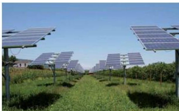
impianto ad inseguimento
