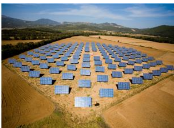
impianto a terra
