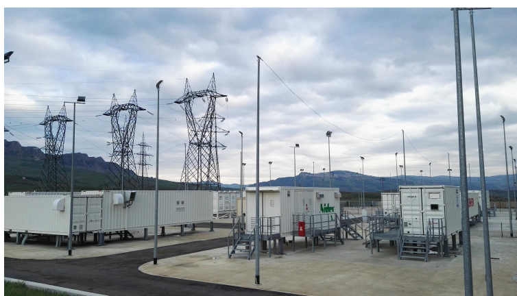
Fig.6: Impianto Storage Lab Power Intensive in Sicilia, presso Ciminna (PA)
