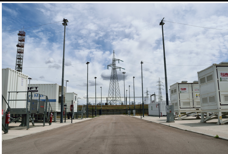
Fig.7: Impianto Storage Lab Power Intensive in Sardegna, presso Codrongianos (CA)
