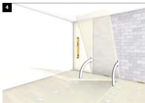
4. POSIZIONAMENTO LASTRE SULLA PARETE
