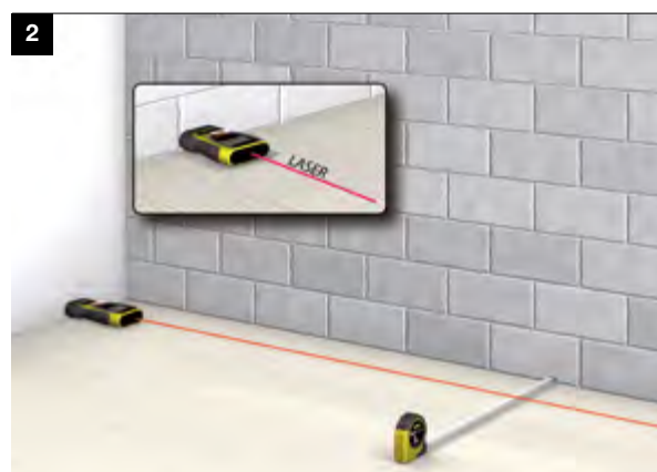
2. TRACCIAMENTO DEL LIMITE ESTERNO DELLA CONTROPARETE
