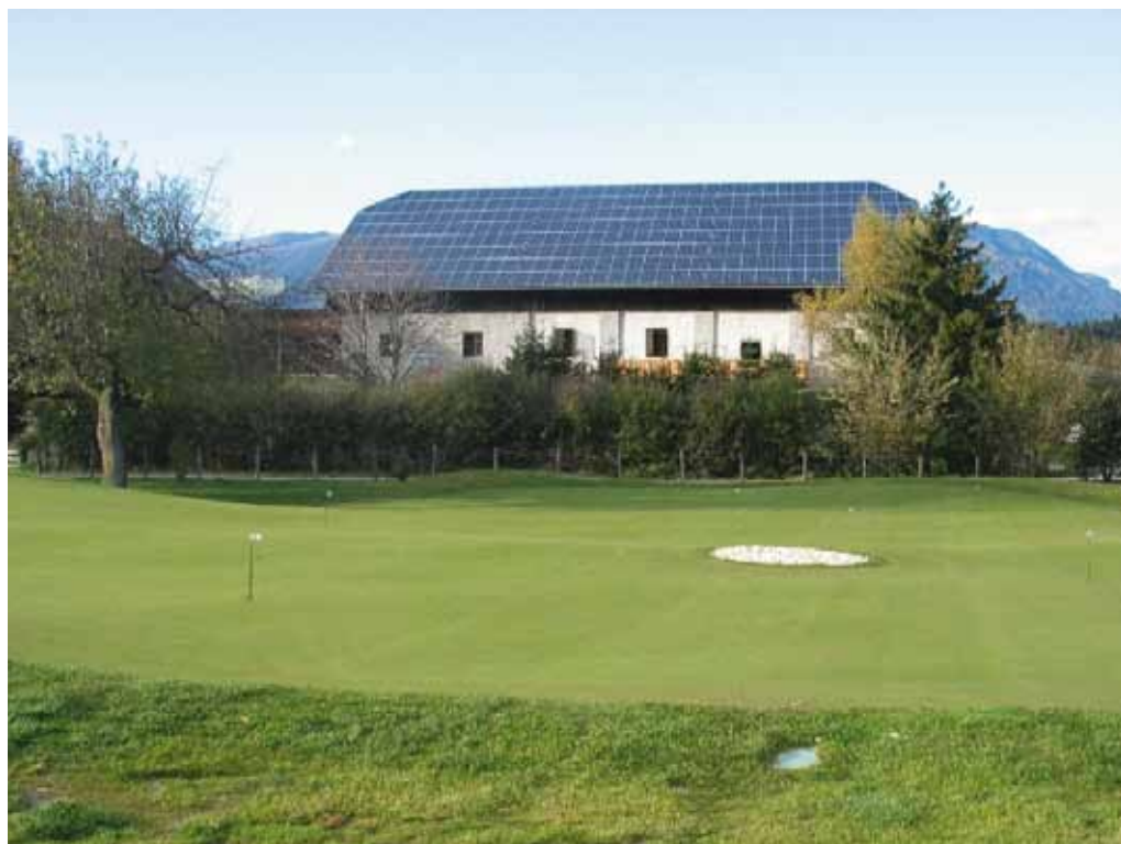
Tetto fotovoltaico su edificio rurale in Provincia di Bolzano
