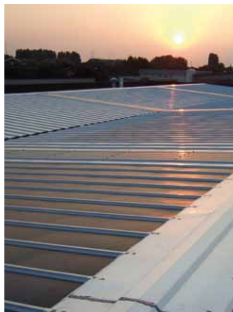
Tetto fotovoltaico nel Comune di Correggio (RE)
