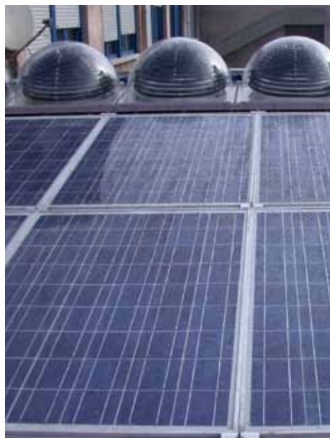
Solare termico Gecolotto integrato con pannelli fotovoltaici, Asti (AT)
