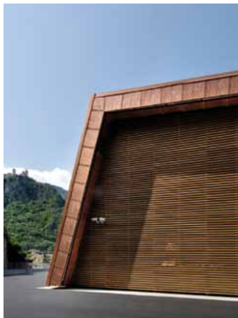
Impianto di teleriscaldamento nel Comune di Chiusa (BZ)
