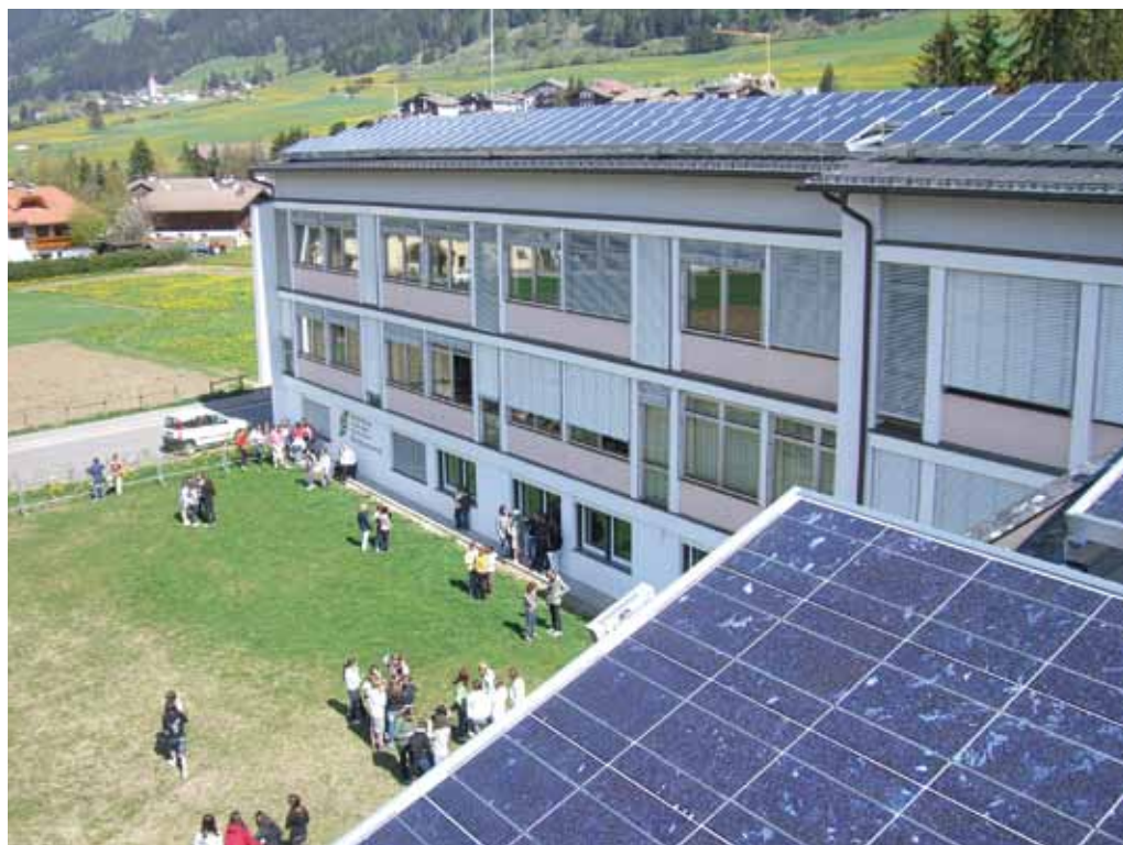
Impianto fotovoltaico scuola elementare Comune di Dobbiaco (BZ)
