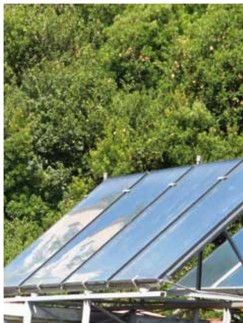
Pannello solare termico su stabilimento balneare, Sperlonga (LT)
