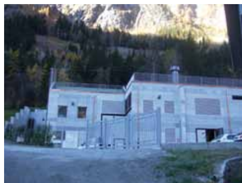
Impianto di teleriscaldamento nel Comune di Prè-Saint-Didier (AO)
