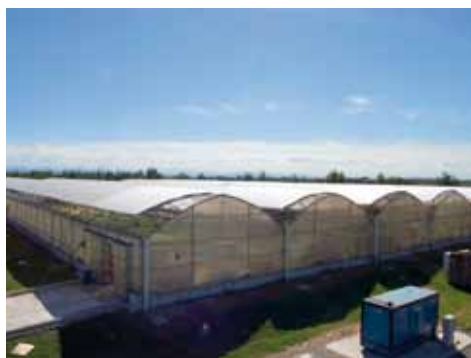
Serra riscaldata da impianto a biogas
