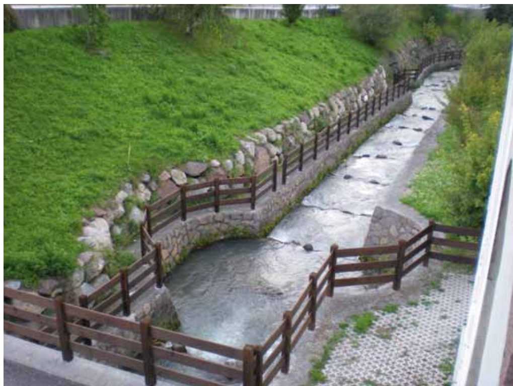
Impianto di risalita dei pesci della centrale idroelettrica "Claudio Castellani" nella Bassa Valle Isarco
