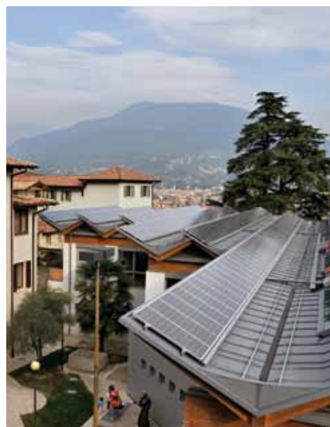
Pannelli fotovoltaici sulla Scuola Materna di Isera (TN)
