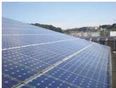
Tetto fotovoltaico sulla sede del GSE
