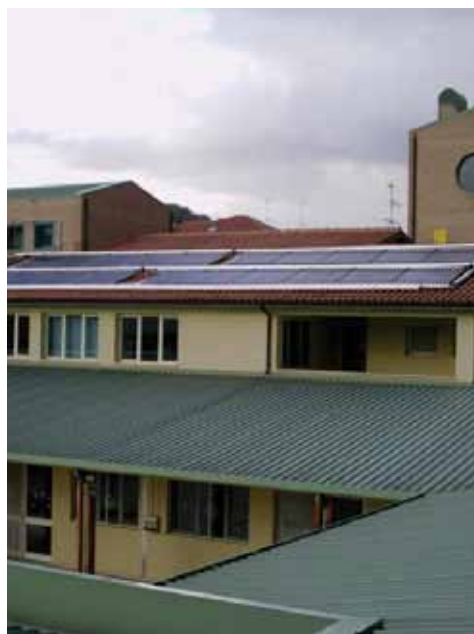
Pannelli solari termici sulla Scuola Materna di San Benedetto del Tronto (AP)
