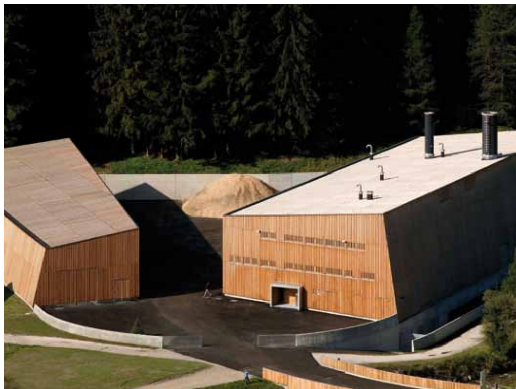
Impianto di teleriscaldamento nel Comune di Sesto (BZ)
