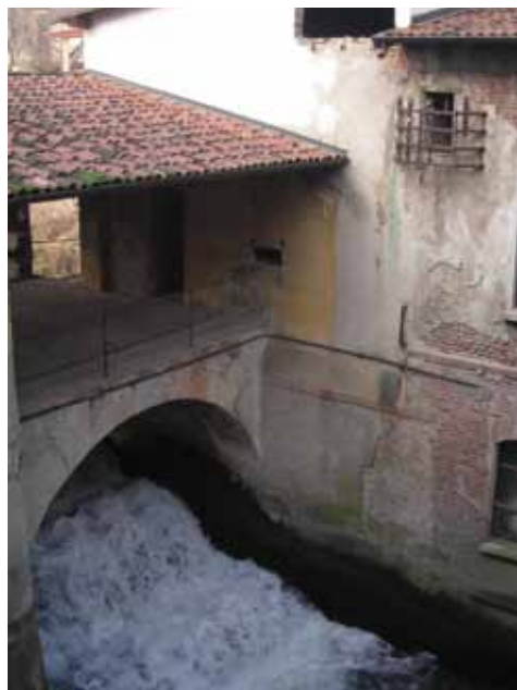
Impianto mini idroelettrico "Treacù" nel Comune di Crema (CR)
