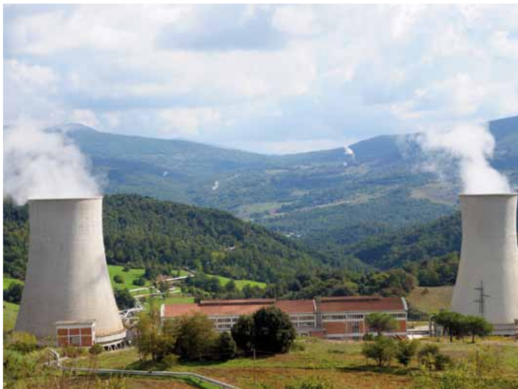
Centrale geotermica nel Comune di Pomarance (PI)
