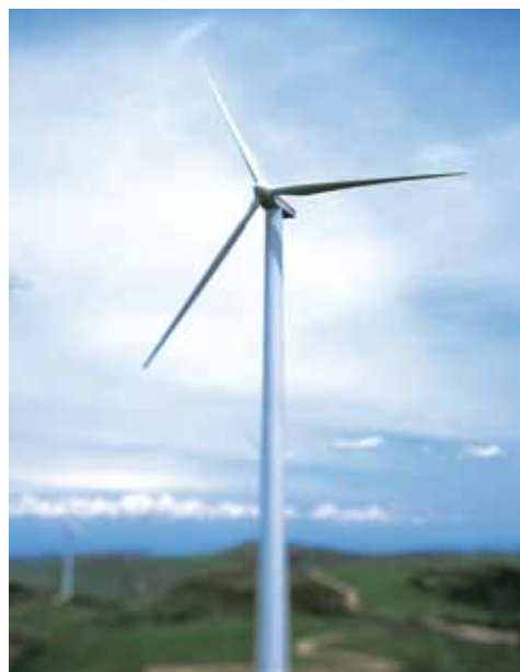
Impianto eolico nel Comune di Sedini (SS)
