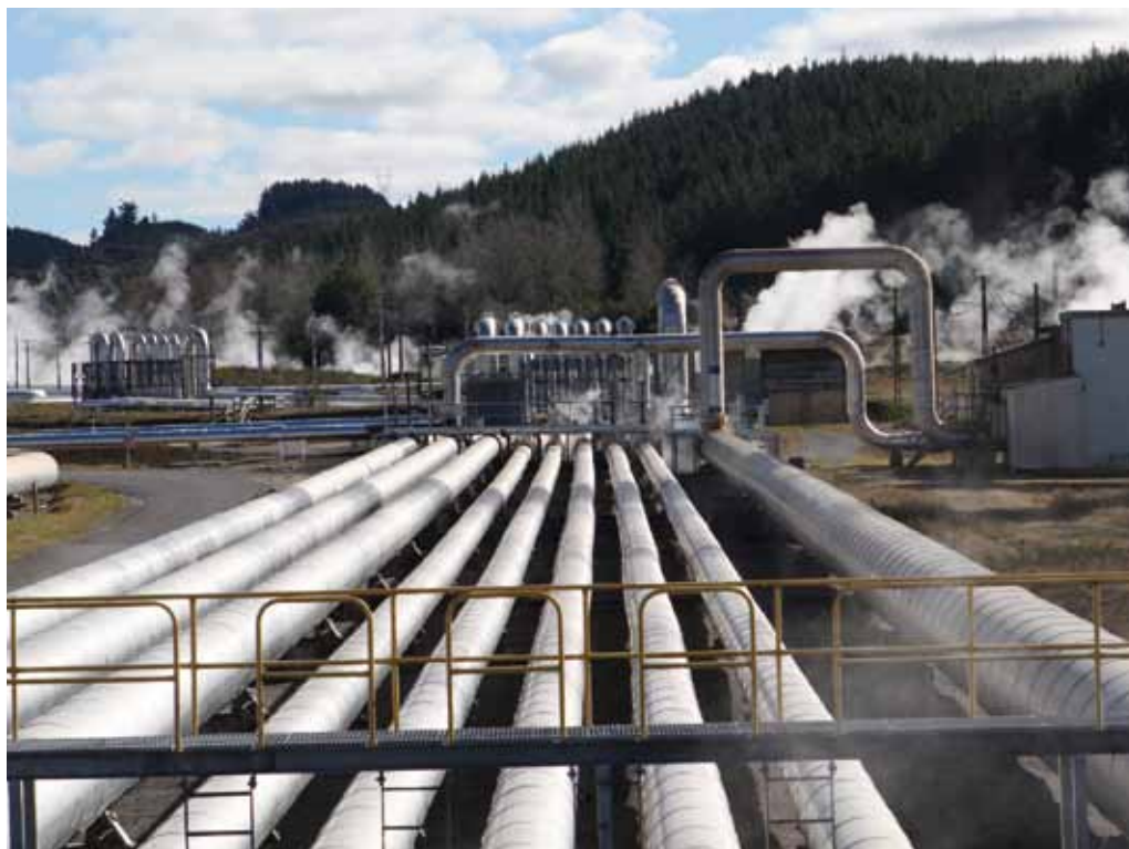
Particolare delle tubazioni di una centrale geotermica
