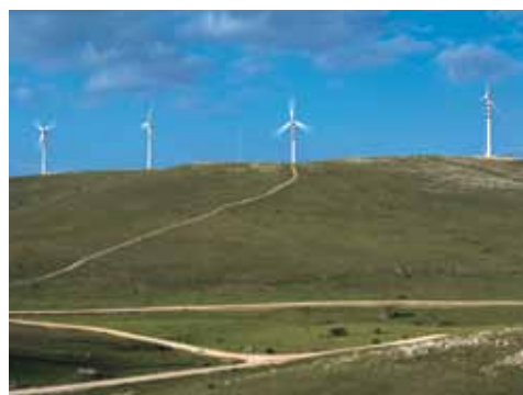
Impianto eolico nel Comune di Cocullo (AQ)
