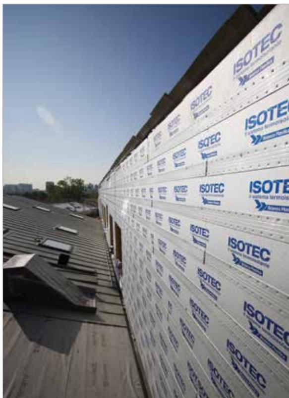
Per l'isolamento termico degli involucri è stato scelto il sistema Isotec Linea con cui è stata realizzata la coibentazione sia delle coperture che delle chiusure verticali, per una superficie complessiva isolata di 2.340 mq. Il sistema Isotec Linea è stato scelto in virtù dell'efficacia del sistema in termini di prestazioni isolanti, oltre che per la facilità di posa e l'ottima compatibilità con il rivestimento in alluminio a doppia aggraffatura.
