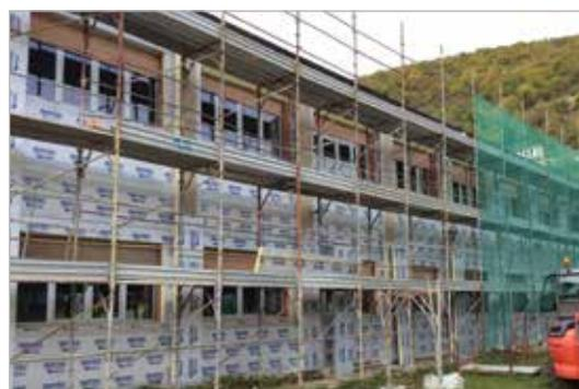
la sola realizzazione dell'isolamento termico esterno e l'installazione di nuovi serramenti. Il lavoro è stato rapidissimo: la posa del sistema isolante e della lastra in fibrocemento, successivamente rasata ad intonaco, si è conclusa in circa due mesi.
