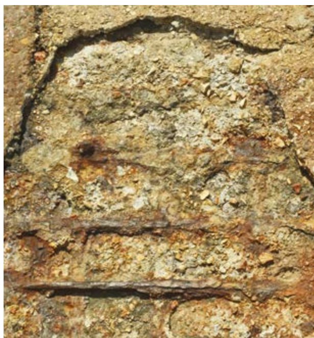
Esempio di corrosione dovuta all'attacco da cloruri.
