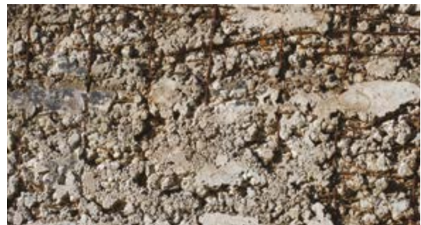
Esempio di segregazione degli aggregati nel calcestruzzo.
