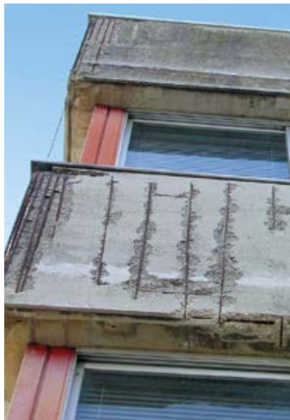
Calcestruzzo con messa a nudo dei ferri d'armatura a seguito del degrado.
