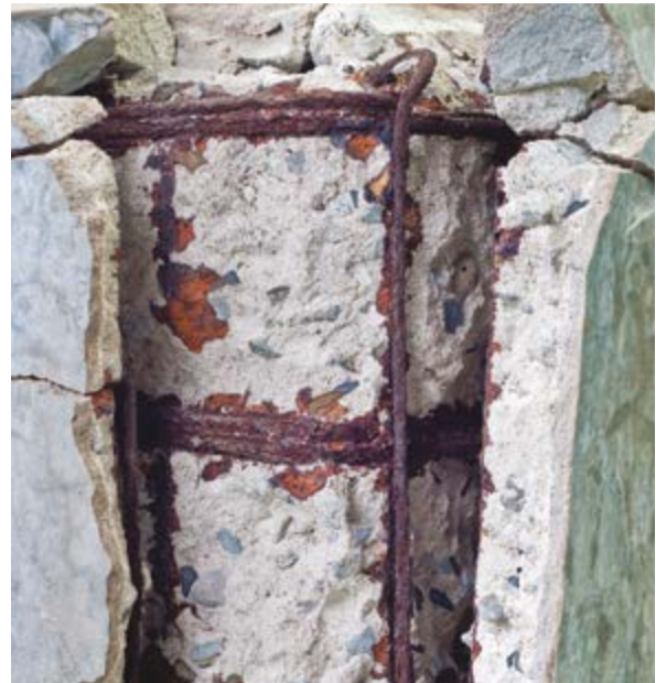
Espulsione del copriferro per arrugginimento dei ferri d'armatura.
