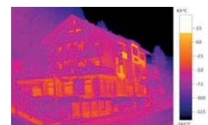
Immagine termica con testo ScaleAssist
