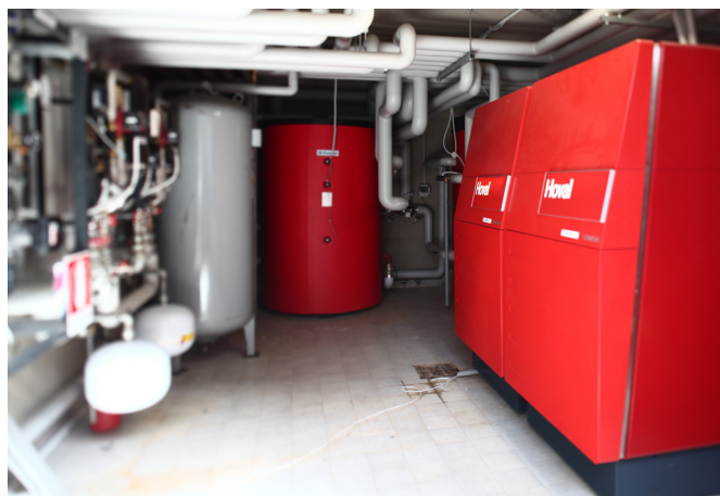
Cascata monovalente costituita da 2 UltraGas in un complesso residenziale di Bresso (MI).
