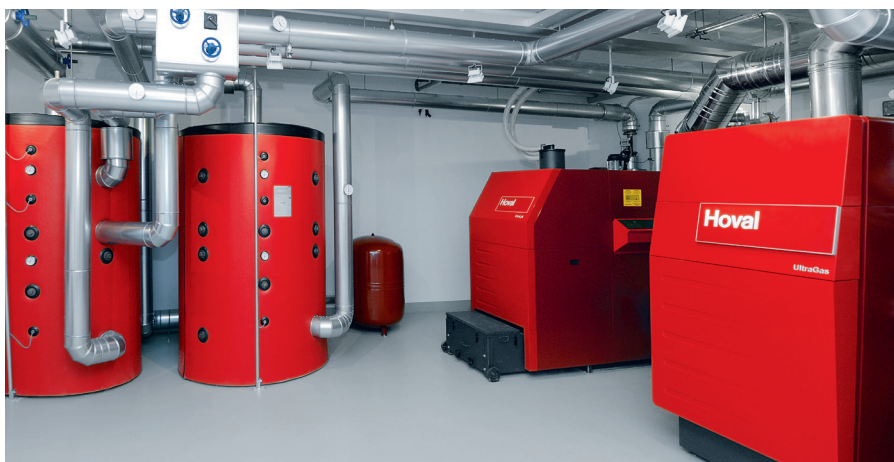
Cascata bivalente in un edificio commerciale nel comune di Aschheim (Monaco): caldaia a pellet BioLyt (160) per il carico base e caldaia a gas a condensazione UltraGas® (250) per la copertura dei carichi di picco.
