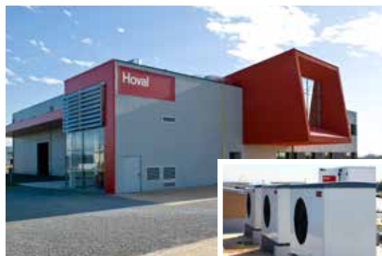
Casa Hoval: 3 pompe di calore aria Belaria® Twin AR collegate in cascata e integrate con una caldaia a gas a basamento Hoval UltraGas® e una caldaia a pellet Hoval BioLyT.
