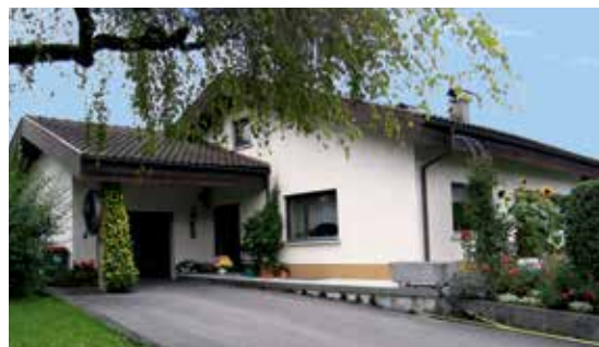
Riqualificazione di un impianto di riscaldamento con un Belaria® compact IR installata internamente.
