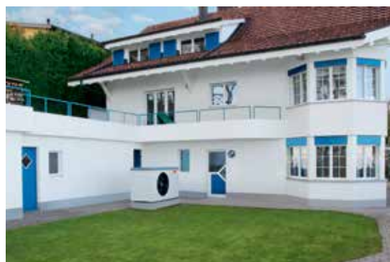
Risanamento dell'impianto di riscaldamento con un Belaria® twin A (17) installato esternamente
