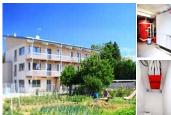
Confortevole clima in ambiente in una palazzina residenziale grazie alla soluzione di sistema Hoval per il riscaldamento, raffrescamento, l'acqua calda sanitaria e la ventilazione meccanica.
