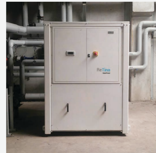
Immagine reale dell'installazione
