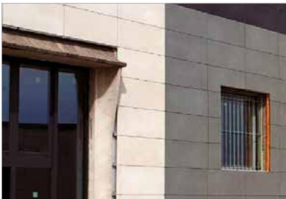
La struttura, interamente prefabbricata in ca, è stata totalmente riefficientata tramite la realizzazione di facciate ventilate con il sistema ISOTEC PARETE dello spessore 80 mm e finitura in grès ceramico, per una superficie totale di 1.100 mq. Con l'intenzione di un rinnovamento completo della sede espositiva e dei magazzini dello showroom, grazie all'altezza contenuta dell'edificio, si è potuto intervenire senza ponteggi, tramite una piattaforma mobile, alla posa del pannello
