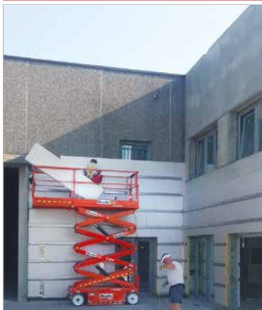
ISOTEC PARETE direttamente sui pannelli di tamponamento prefabbricati in ca. Successivamente si è proceduti alla posa di lastre in grès del formato 60 x 120 mm di tre differenti colorazioni, che hanno ravvivato e reso l'estetica dell'edificio più elegante ed accattivante. L'intera operazione si è svolta nei tempi pattuiti con il committente e nella piena soddisfazione dello stesso per l'ottimo risultato estetico finale.
