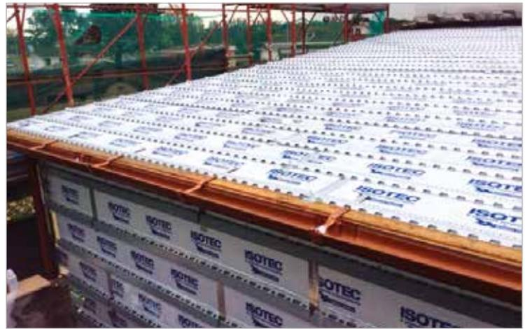
La palazzina, edificata nella metà degli anni '70, era afflitta da diverse problematiche. Per la copertura, si è scelta la completa rimozione dei travetti esistenti, delle vecchie strutture autoportanti in cemento e della copertura in lamiera, realizzando un nuovo pacchetto alleggerito in travi in legno lamellare, sistema isolante in poliuretano ISOTEC di Brianza Plastica, nello spessore 120 mm e lastre in PVC effetto tegola invecchiata, fissate direttamente al correntino metallico.
