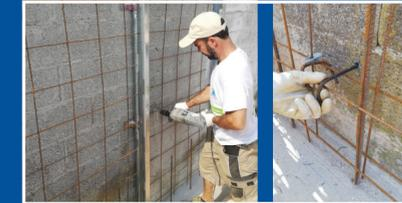
Posizionamento della rete metallica sulla parete e successivo inghisaggio dei connettori con ancoraggio chimico
