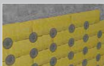
Installazione a filo parete con dischi DT di pannelli in lana minerale su parete in calcestruzzo
