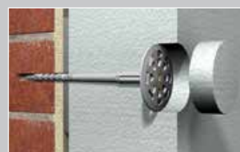
Installazione a scomparsa con dischi copriforo di pannelli in polistirene espanso
