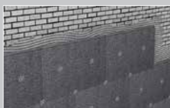
Installazione a filo parete di pannelli in polistirene grafitato su mattoni in silicato di calcio
