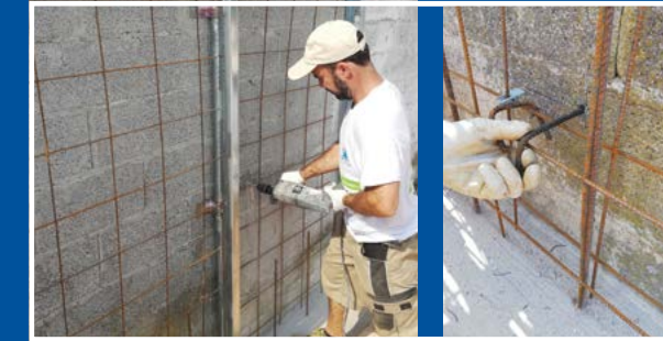
Posizionamento della rete metallica sulla parete e successivo inghisaggio dei connettori con ancoraggio chimico
