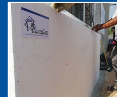
Posa dei pannelli isolanti da cappotto
