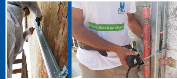
Posizionamento e fissaggio dei profili metallici verticali, laminati a freddo per uso strutturale
