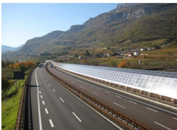
impianto su autostrada (barriera acustica)
