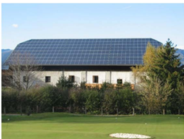
impianto su capannone
