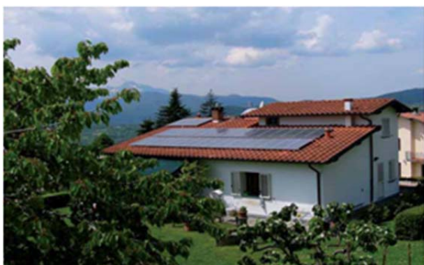
impianto a servizio di abitazione
