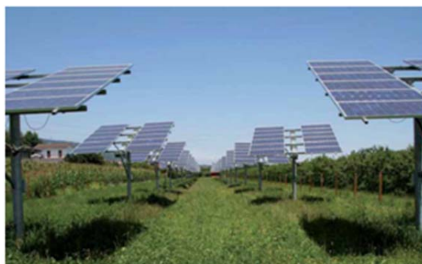
impianto ad inseguimento
