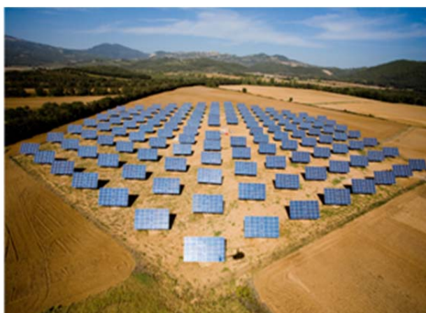
impianto a terra
