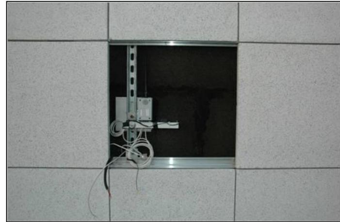
L'apparato di monitoraggio è modellato in ogni sua singola componente; così le centraline wireless che accolgono i circuiti di registrazione e trasmissione dati, allocate nell'intercapedine. Alimentate da due circuiti elettrici separati, comunicano i dati rilevati ad una sottorete gestita da EEEPC.
