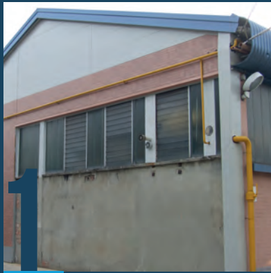
PARETE DA RIVESTIRE WALL TO BE CLAD
