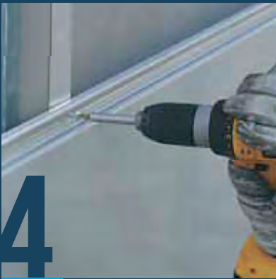
FISSAGGIO DEL PRIMO PANNELLO ALLA BASE DELLA FACCIATA FASTENING OF FIRST PANEL TO FACADE BASE
