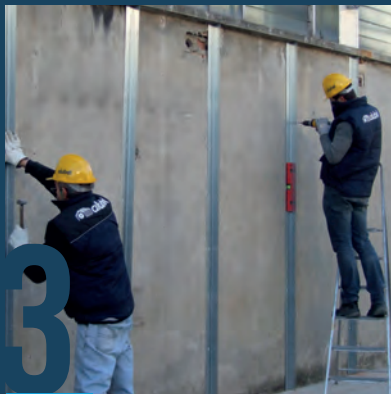
FISSAGGIO DELLA SOTTOSTRUTTURA ALLA PARETE PORTANTE IN SERIE SEQUENTIALLY FASTENING OF SUB-STRUCTURE TO BEARING WALL
