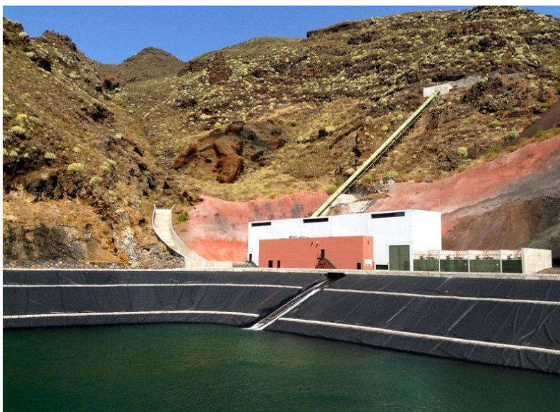
Bacino di raccolta della centrale idroeolica
