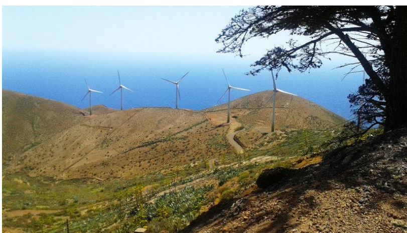
Aerogeneratori della centrale idroeolica
