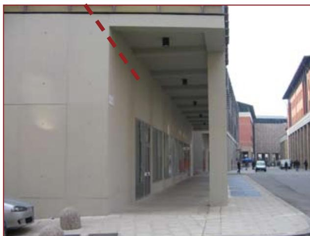
Le strutture “a sbalzo” verso l'esterno possono diventare ponti termici ed essere elementi di dispersione del calore se non adeguatamente isolate
