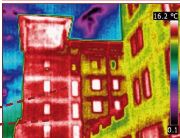
La struttura in cemento armato non isolata ed il contatto del solaio con le pareti creando vie preferenziali per la dispersione del calore verso l'esterno
