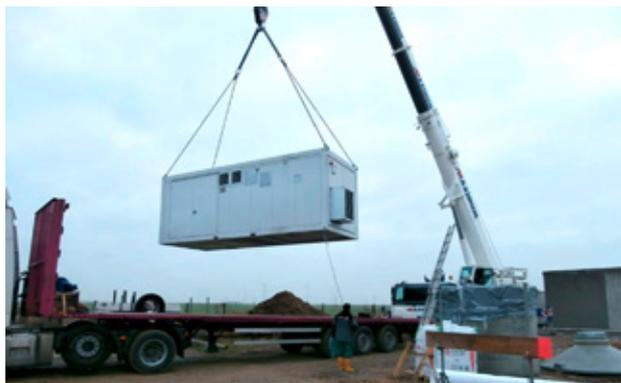
b) generatore di gas di legno + motore preinstallato da montare negli edifici esistenti
