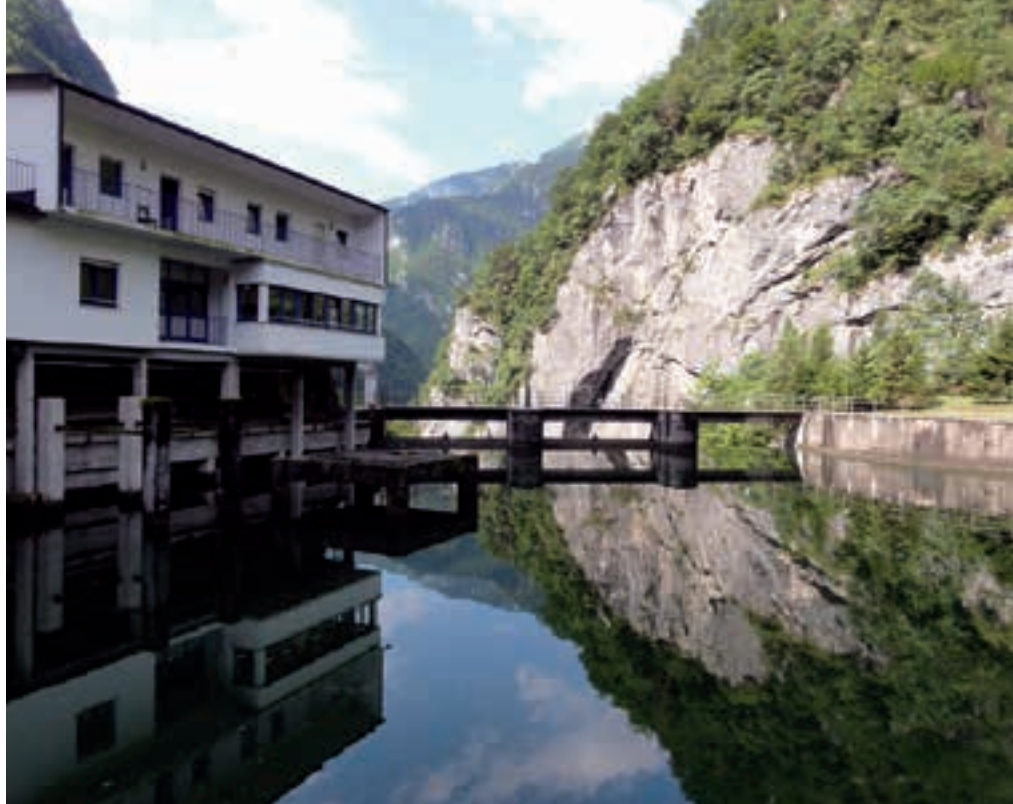
Impianto idroelettrico, Valli Primiero e Vanoi
