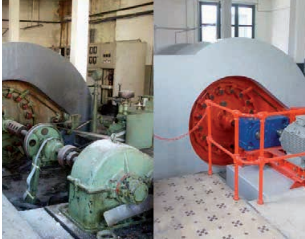
Revamping impinato idroelettrico, Comune di Nembro (BG)
