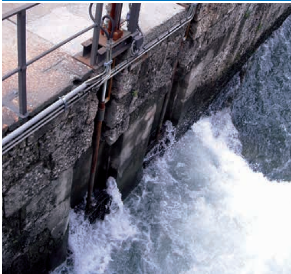
Impianto mini idroelettrico, Comune di Milano
