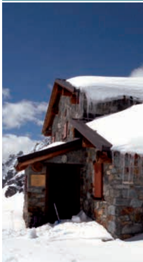
Rifugio Perrucca, servito da impianto mini idro Comune di Valtournenche (AO)
