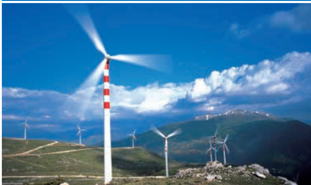
Impianto eolico Comune di Cocullo (AQ)
