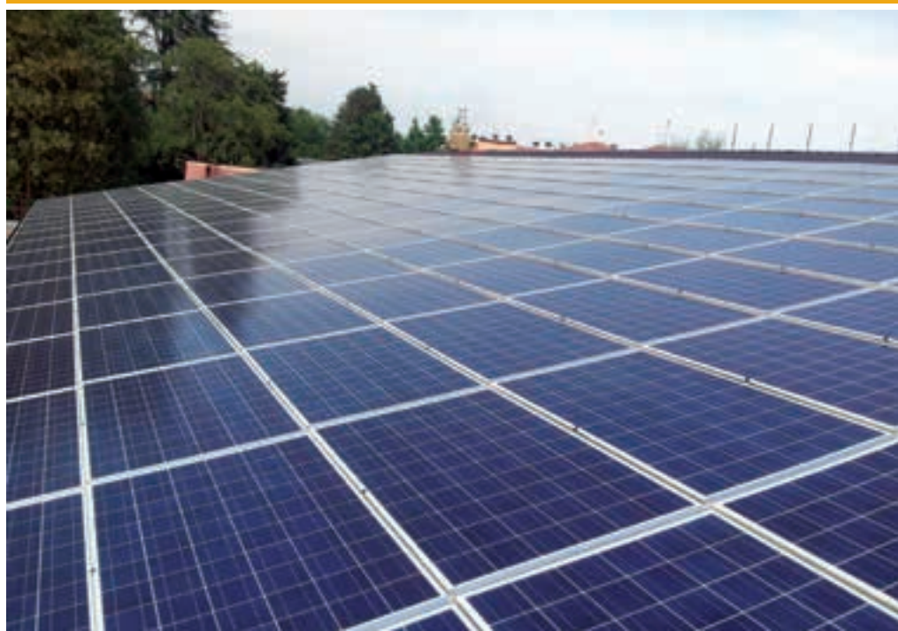
Impianto fotovoltaico su copertura scuola materna, Comune di Renate (MB)
