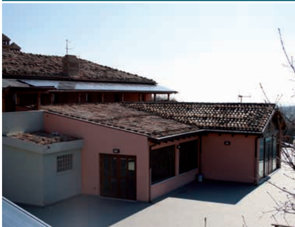
Casa autosufficiente, Comune di Penne (PE)
