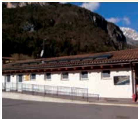
Impianto solare termico su copertura camping, Comune di Molveno (TN)
