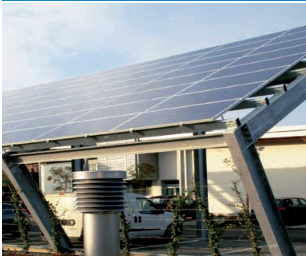
Impianto solare fotovoltaico su pensilina, Comune di Conselice (RA)
