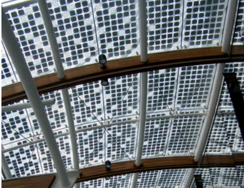
Impianto fotovoltaico integrato nella copertura, piazza Porta Nuova, Comune di Milano
