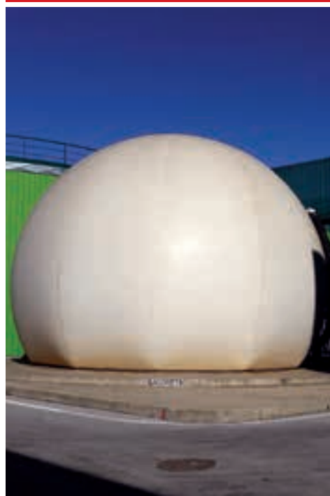
Gasometro impianto di compostaggio, Comune di Salerno
