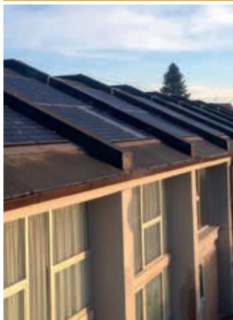
Pannello solare fotovoltaico su scuola materna, Comune di Sarteano (SI)
