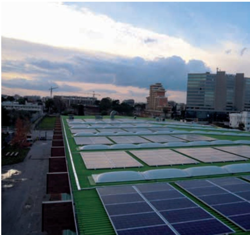
Impianto fotovoltaico su edificio pubblico, Comune di Bari
