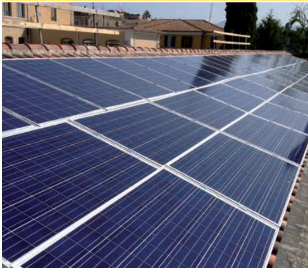
Pannello solare fotovoltaico su scuola, Comune di Magliano Sabina (RI)
