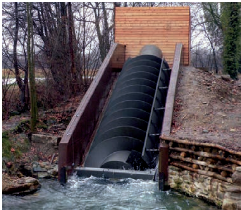
Impianto mini idroelettrico a vite di archimede, Comune di Oglianico (TO)
