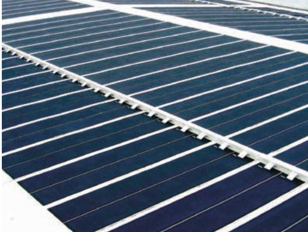
Impianto solare fotovoltaico su capannoni industriali
