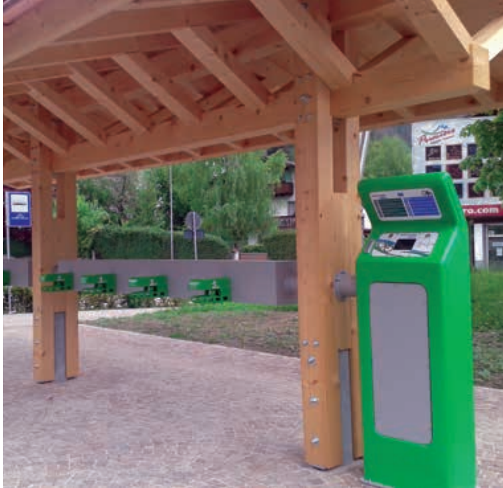
Sistema di ricarica elettrica bikesharing, Comuni di Primiero e Vanoi (TN)
