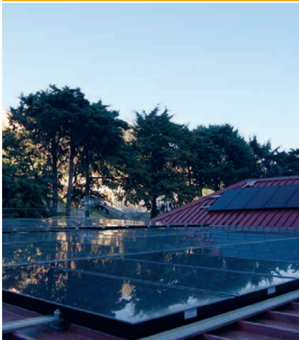
Impianto solare fotovoltaico su copertura magazzino, Comune di Collesalveti
