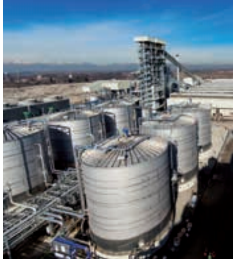
Bioraffineria nel Comune di Crescentino (VC)
