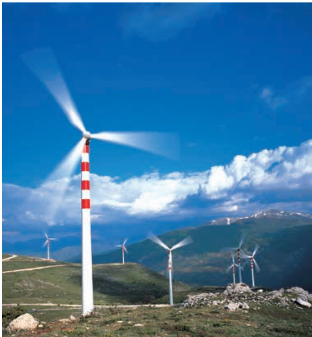
Impianto eolico Comune di Cocullo (AQ)
