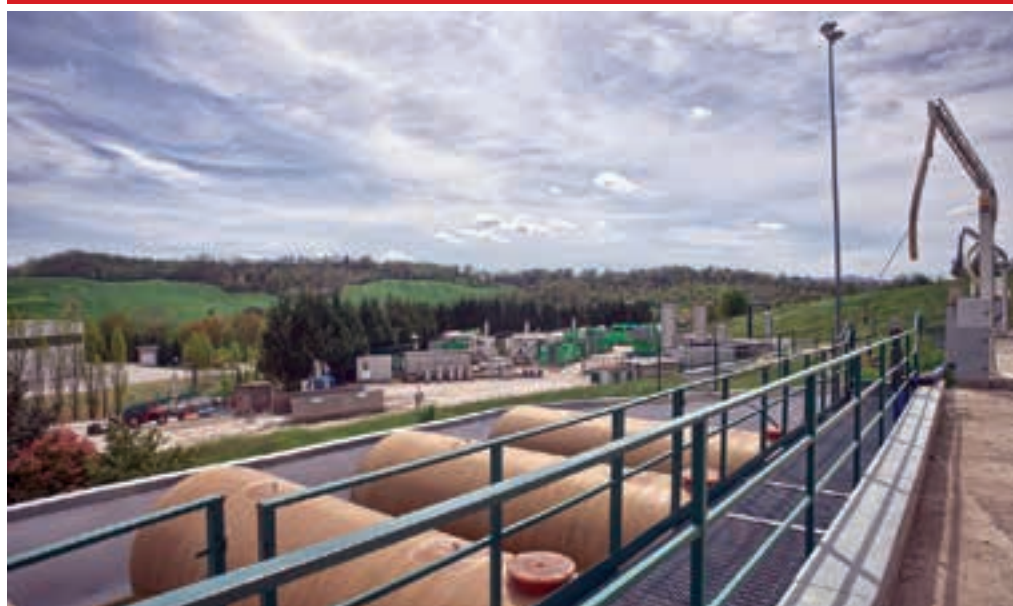
Particolare di impianto a biogas su discarica, Comune di Terranuova (AR)
