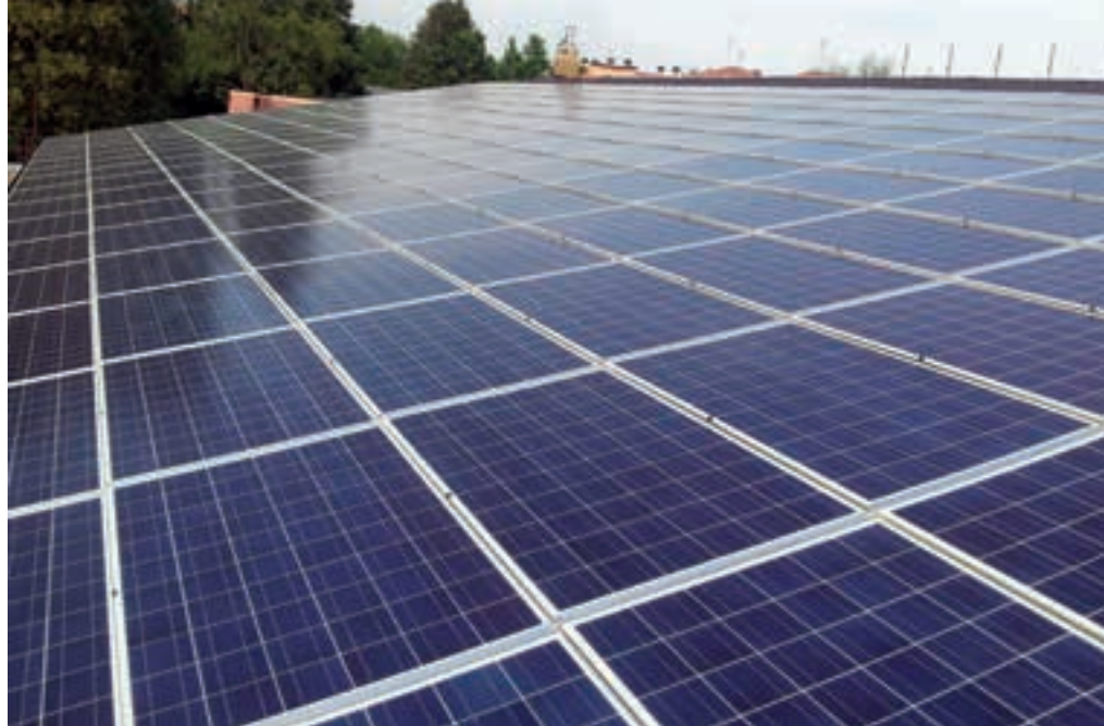
Impianto fotovoltaico su struttura scolastica, Comune di Renate
