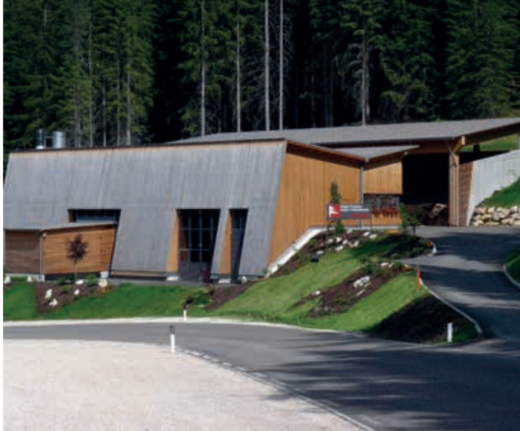
Impianto di teleriscaldamento, Comune di Obertein (BZ)
