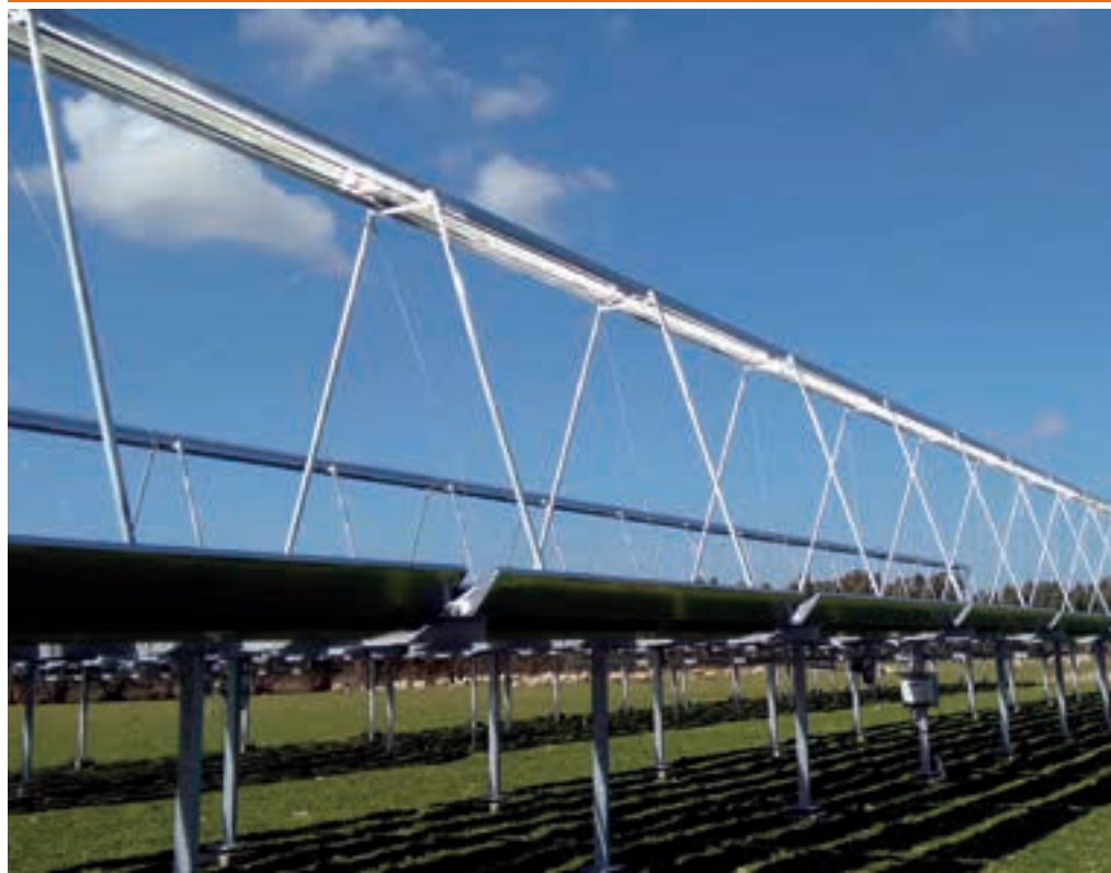
Impianto solare a concentrazione, Comune di San Niccolò (OR)
