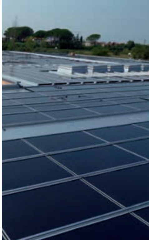
Pannello solare termico nel Comune di Cascina (PI)
