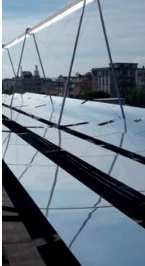
Impianto solare a concentrazione, Comune di Rimini
