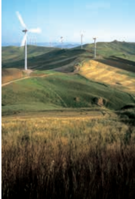
Impianto eolico, Comune di Raddusa (CT)
