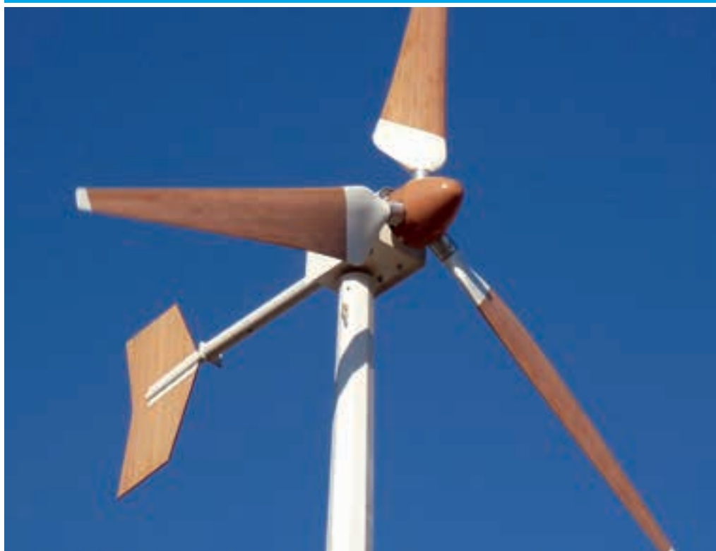
Impianto di minieolico di Farnetta, Comune di Montecastrilli (TR)
