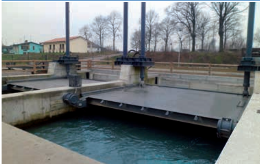
Impianto mini idroelettrico, Comune di Isola Dovarese (CR)
