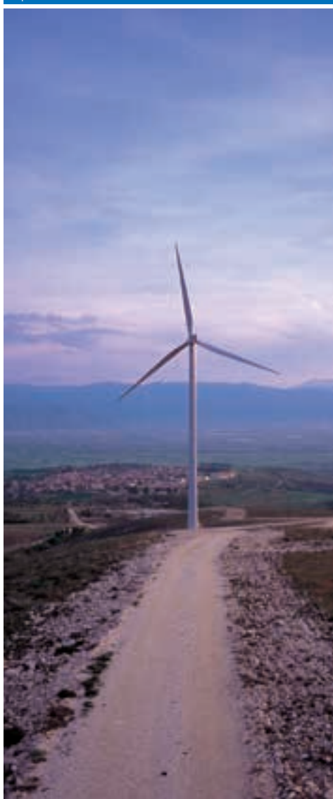
Impianto eolico, Comune di Collarmele (AG)
