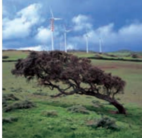
Parco eolico, Comune di Nulvi (SS)
