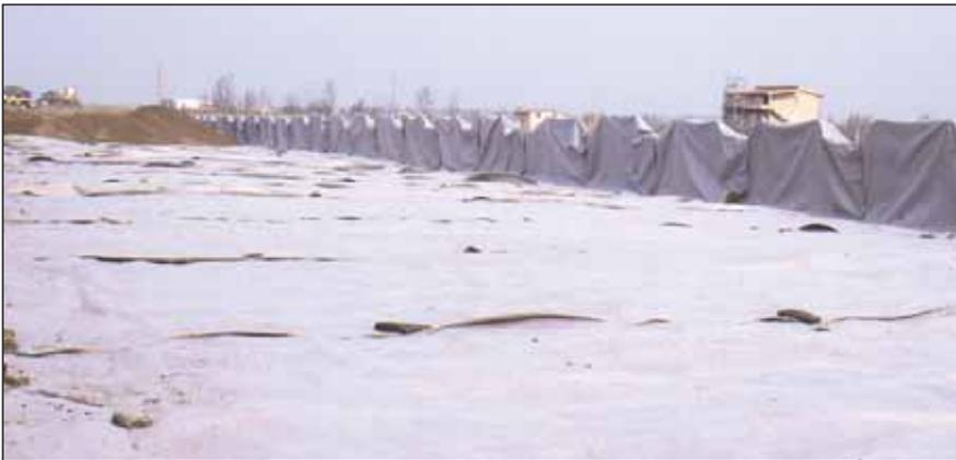
Scavo per la costruzione del rilevato compensato della terza corsia dell'autostrada Roma Civitavecchia.
