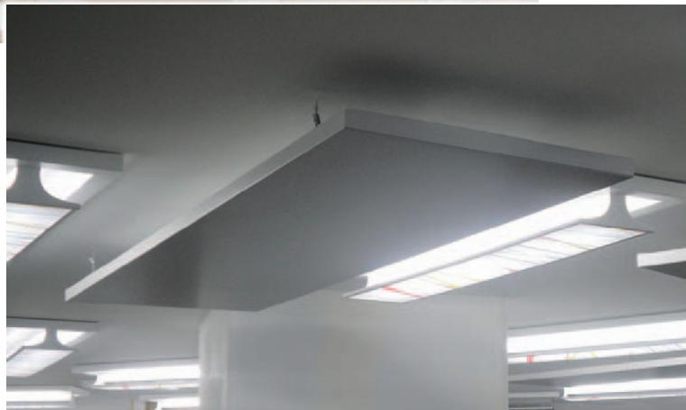
Il pannello è alimentabile sia ad acqua calda che ad acqua fredda: nei periodi estivi è consigliabile l'abbinamento con un sistema ad aria primaria, dato che la resa è unicamente sensibile.
