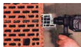
Applicazione del telaio su mattone forato
