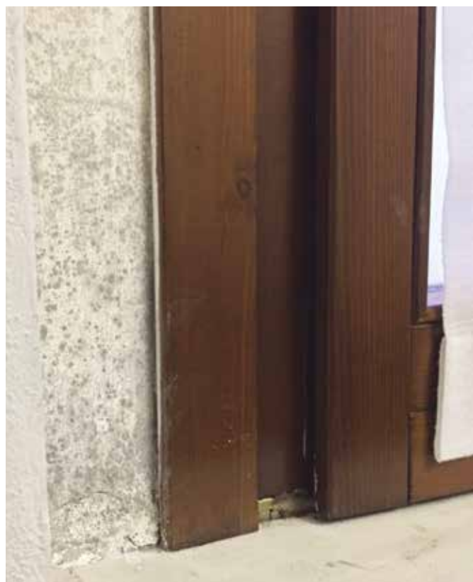
► Formazione di muffa causata da un ponte termico.
