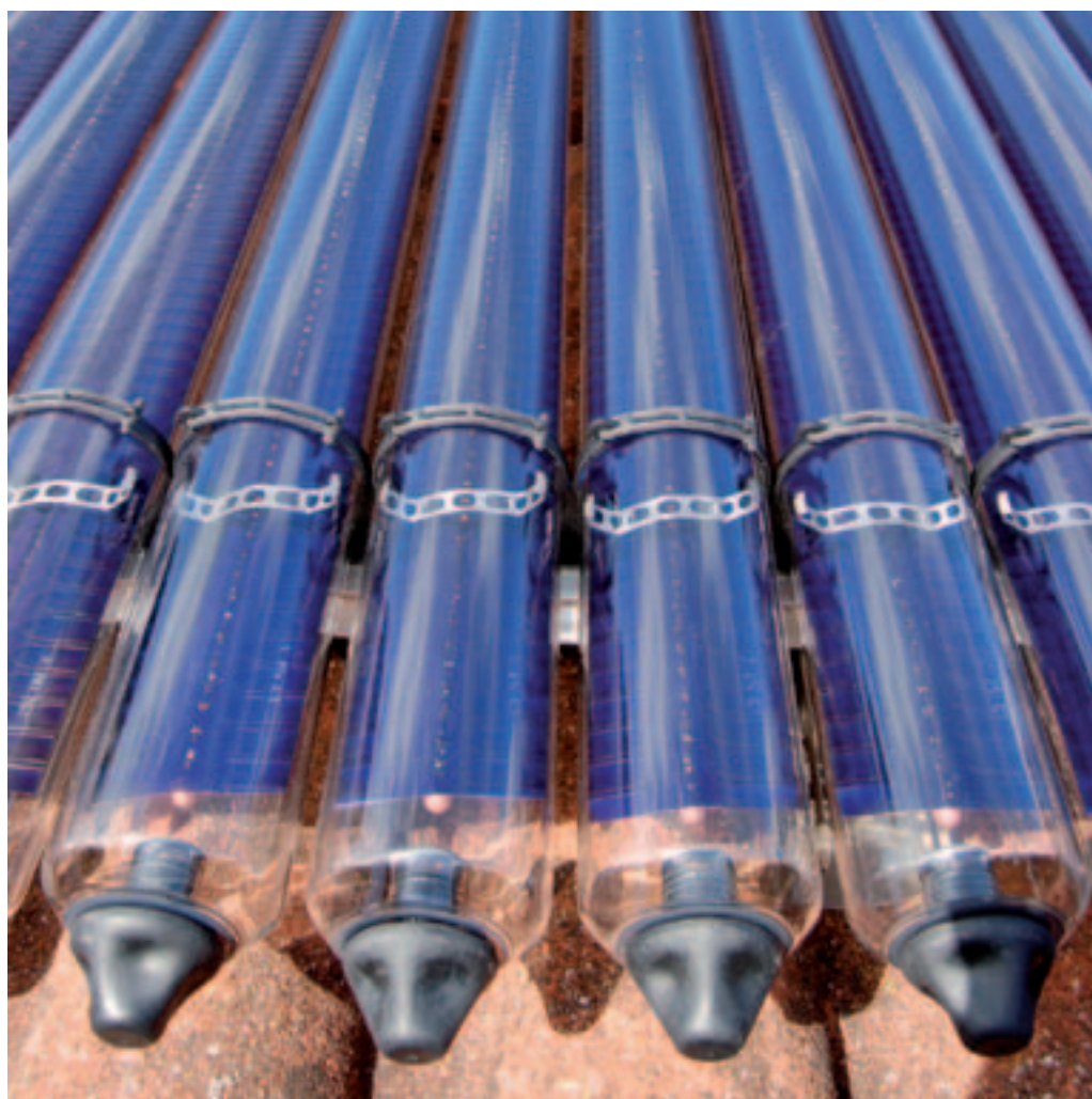
Particolare di un pannello solare termico
