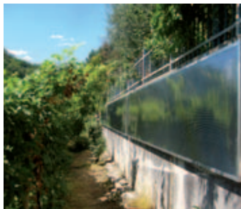
Impianto solare termico verticale, giardino privato, Comune di Vittorio Veneto (TV)
