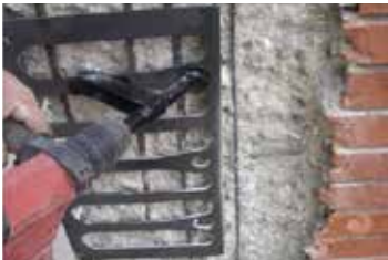
4_ APPLICAZIONE DELL'INSERTO E FORATURA A PROFONDITA' E DIAMETRO COME DA PROGETTO
