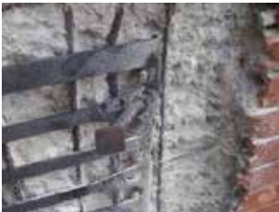
5_ PULIZIA DEI FORI, IMMISSIONE DEL LEGANTE E IMMISSIONE DEI TIRANTI A TESTA A SCOMPARSA
