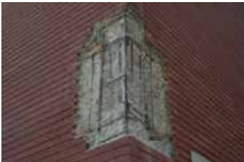
1_ RIMOZIONE DEL RIVESTIMENTO E DEL COPRIFERRO. PASSIVAZIONE DELLE ARMATURE
