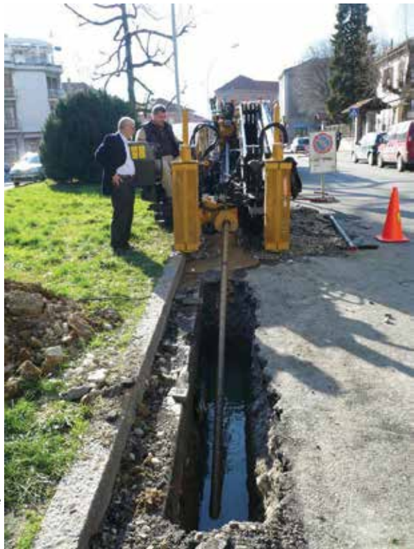
Cantiere HDD
