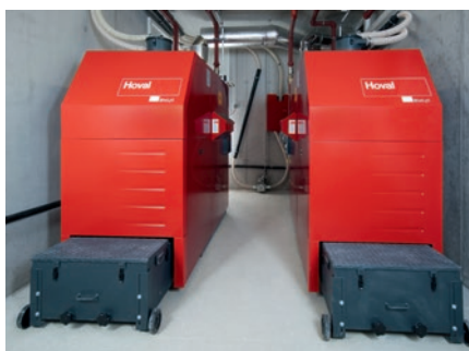
Centrale termica con 2 caldaie a pellet BioLyt in cascata.
