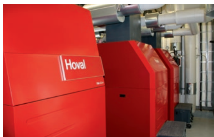
Centrale di energia con cascata, composta da 2 caldaie a pellet BioLyt e 1 caldaia a condensazione a gas UltraGas.
