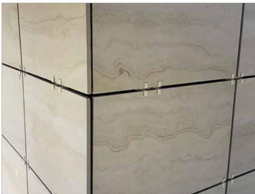
Per la realizzazione dell'isolamento ventilato delle facciate, sia di nuova costruzione che esistenti, è stato impiegato il sistema Isotec Parete di Brianza Plastica. La **posa** è avvenuta **completamente a secco**, assicurando la massima pulizia del cantiere e perfetta lavorabilità in tutte le condizioni climatiche. Le lastre in gres porcellanato 30x60 cm sono state ancorate ai correntini mediante morsetti in acciaio verniciati nel colore delle piastre.
