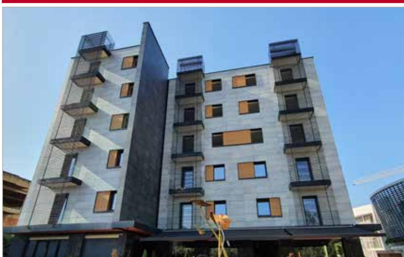
Per il rivestimento delle facciate si è optato per un'estetica classica ed elegante, con rasatura ad intonaco realizzata avvitando lastre portaintonaco in cemento portland direttamente al correntino metallico del sistema di isolamento ventilato Isotec Parete. Una volta posate le lastre, si è proceduto alla stuccatura dei giunti ed alla rasatura e successiva pittura in un'elegante bicromia nei toni del bianco e del grigio.
