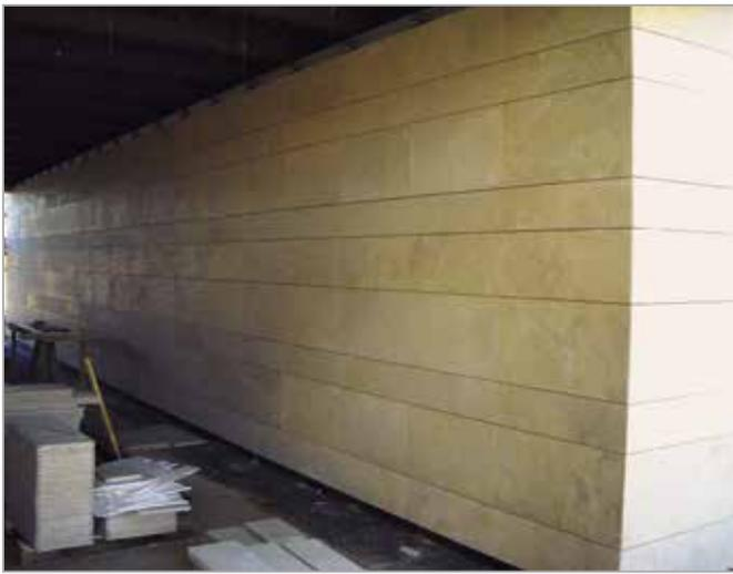
Per la realizzazione della facciata ventilata è stato scelto il sistema Isotec Parete, nello spessore 80 mm e passo 73 cm, installato in verticale. Il correntino assicura l'attivazione della ventilazione naturale fra il rivestimento e il pannello, mentre dal punto di vista statico costituisce il supporto ottimale e versatile per tutti i tipi di rivestimento per facciata. In questo caso il rivestimento scelto sono state lastre di travertino fibrorinforzato in intradosso, nello spessore 20 mm.
