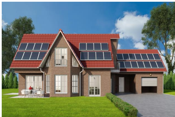
impianto a servizio di abitazione
