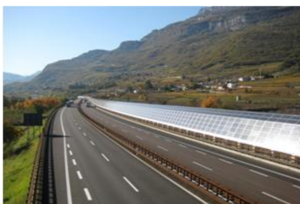
impianto su autostrada (barriera acustica)
