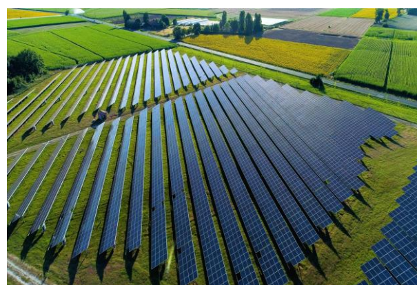
impianto a terra
