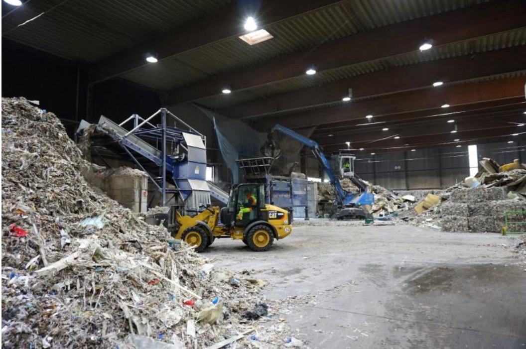
Figura 7: impianto della Nehlsen (D) per il trattamento dei rifiuti in vetroresina e la loro riformulazione con residui della lavorazione della carta da usare come materia prima per la produzione di cemento (fonte: Bremeninvest, 2018)
