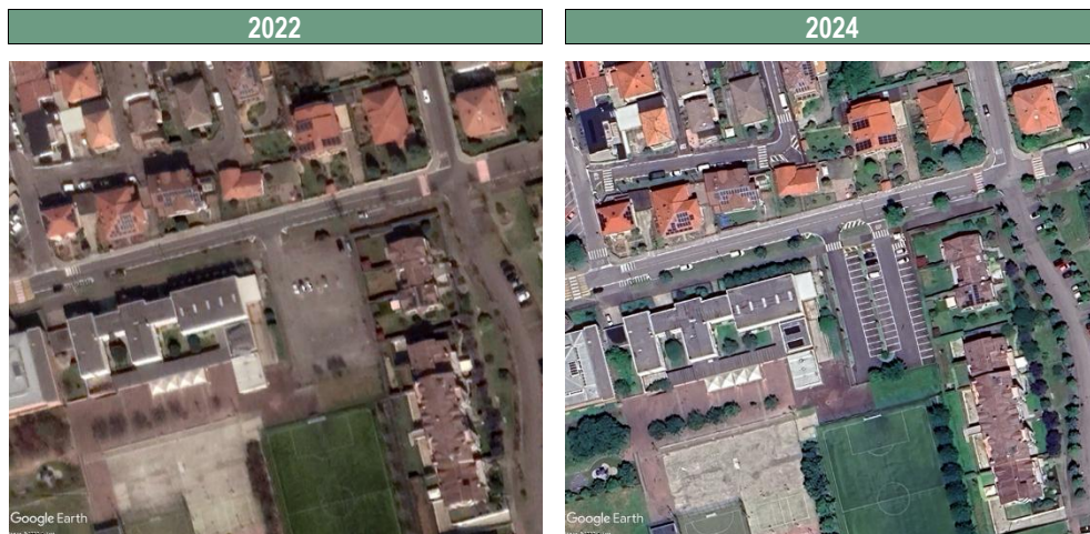
Figura 181. Immagini pre e post-intervento nel parcheggio di via Friuli
