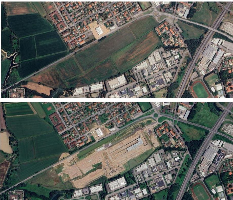
Figura 103. Cantiere per la realizzazione di un nuovo data center nel comune di Noviglio (Milano) di circa 14 ettari. Immagini 2023 e 2024
