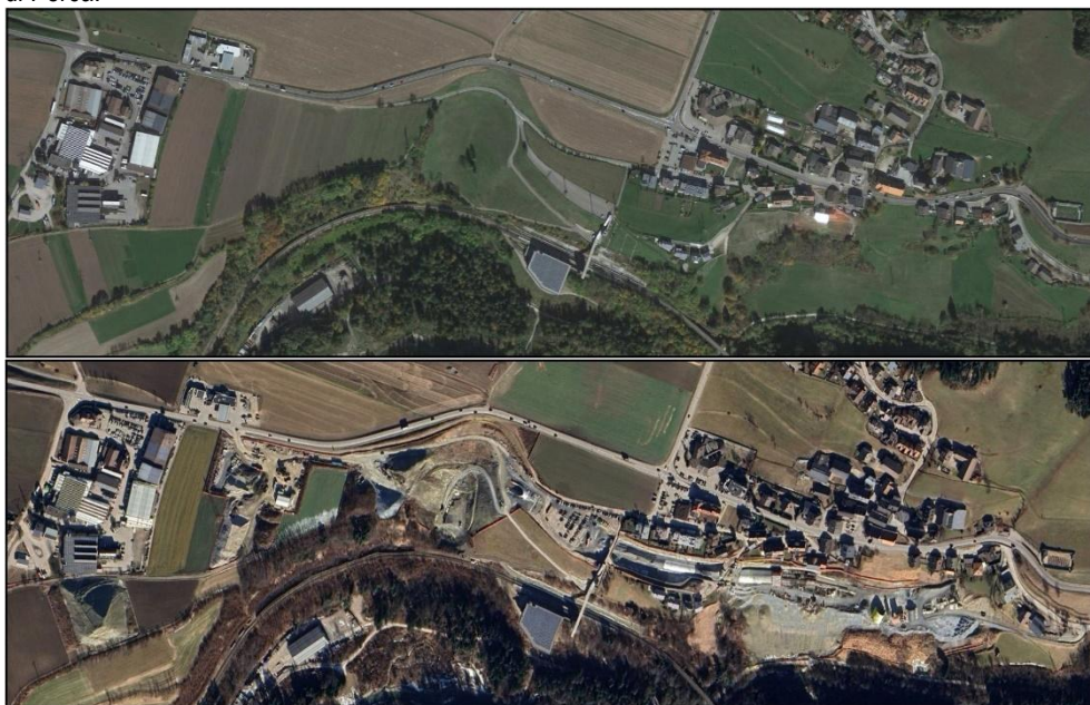
Figura 110. Nella parte superiore, l'area interessata dall'intervento prima dell'inizio dei lavori, mentre nella parte inferiore è rappresentata l'area di cantiere relativa all'intervento descritto, con una superficie di circa 10 ettari
