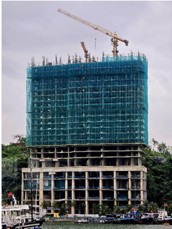
Figura 1. Edificio in costruzione
