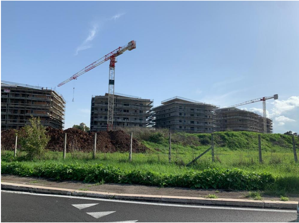
Figura 85. Nuovi edifici di edilizia convenzionata in costruzione nel decimo municipio del comune di Roma
